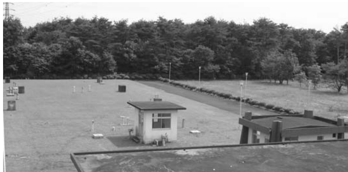
千本松浄水場内高地区配水池
