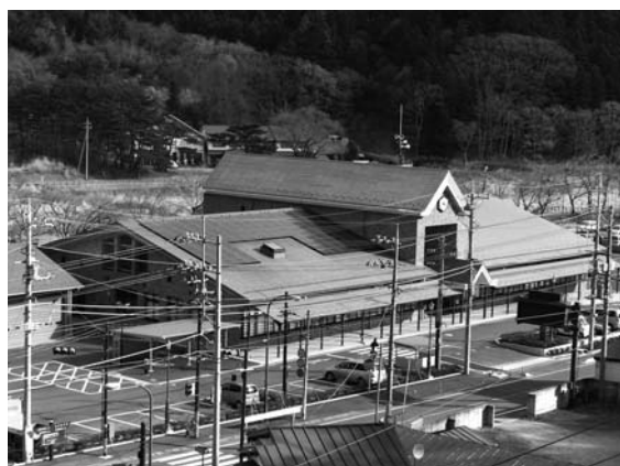
太陽光発電パネル・那須塩原市塩原支所
