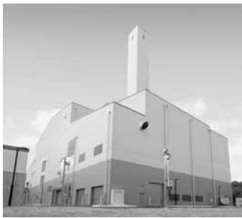
熱回収施設棟
