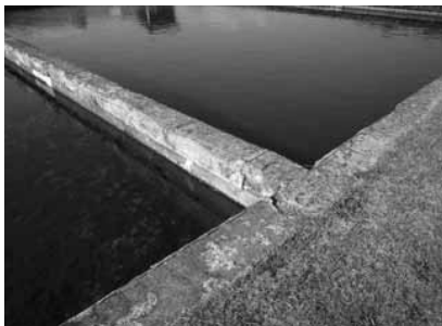
鳥野目浄水場 緩速ろ過池
