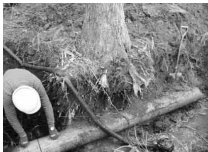
石綿セメント管の布設状況
