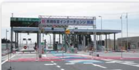
黒磯板室インターチェンジ開通
