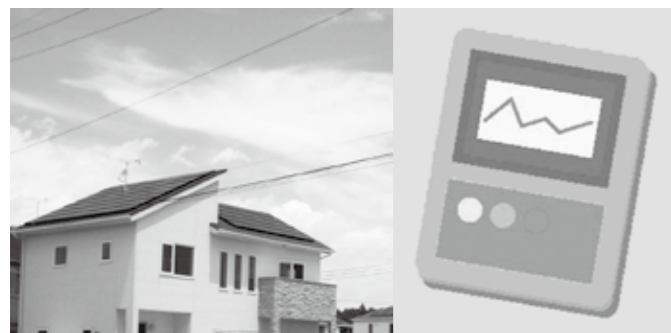
住宅用太陽光発電システム
