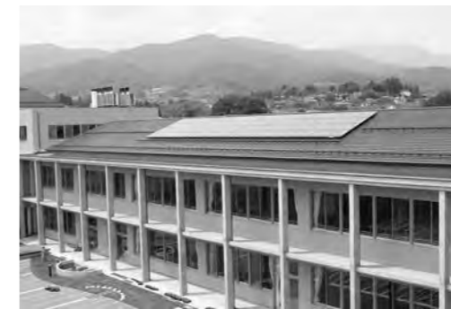
高森中学校に設置された太陽光発電装置
