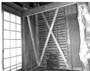
耐震改修工事の様子
