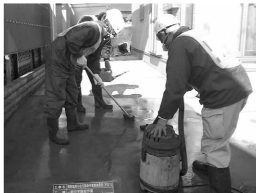
コンクリート洗浄による除染
