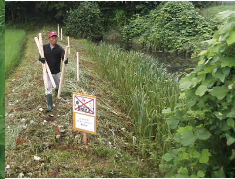
↑ 群生地周りのくい打ち作業。"とる"のは写真だけにしましょう
