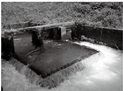
サイフォンの原理で蛇尾川の下をくぐり抜けてきた疏水は、上横林地内 で再び地上に出て流れて行きます
