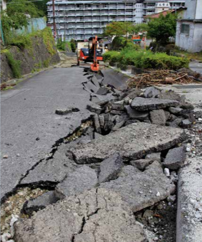
↑市道区画街路17号線の舗装の一部が崩落(ホテルニュー塩原付近)
