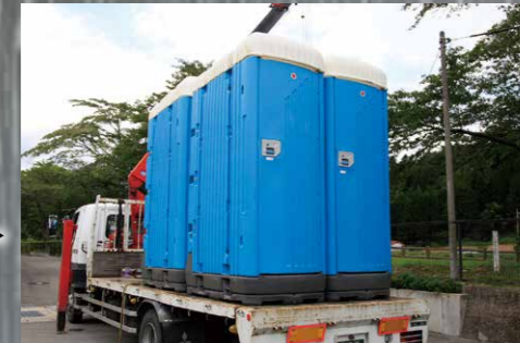
断水対策として、塩原一地区の3カ所に給水所と7カ所に仮設トイレを設置しました
