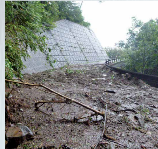
↑土砂崩れにより市道日新湯線の通行が寸断
