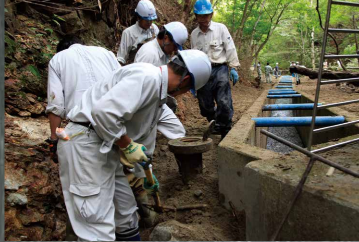
↑中山配水池と要害浄水場への原水の流入が途絶え、塩原地区の一部(940戸)で断水が発生。写真は要害浄水場の取水施設の復旧作業の現場
